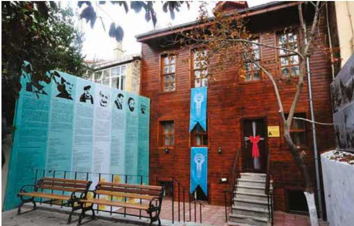
Sezai Karakoç Hizmet Binası
