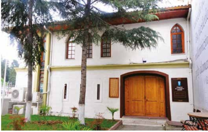
Ahmet Yesevî Hizmet Binası
